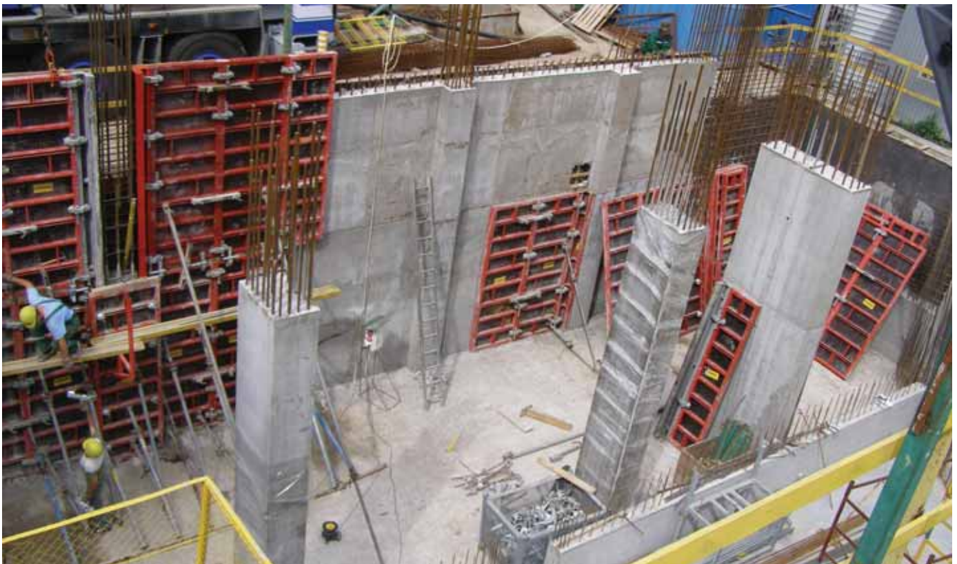
Підземний паркінг, стіни із вбудованими колонами, м. Київ, опалубка ROBUD STAYER
